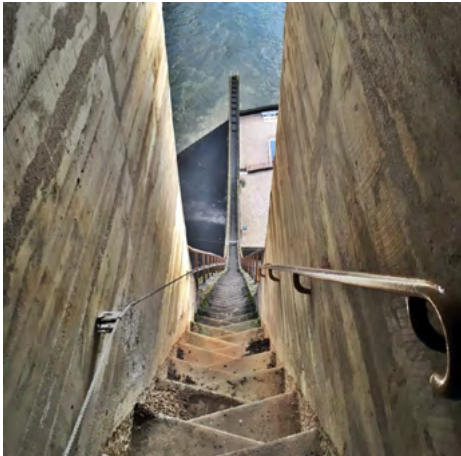
Escalier le long des évacuateurs de crue du barrage de l'Aigle
